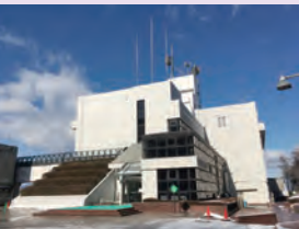
広島市総合防災センター
