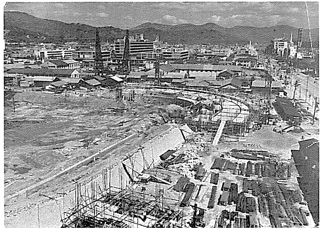
建設中の広島市民球場 その他資料 カ04-001
