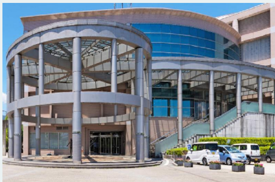
廿日市市スポーツセンター
