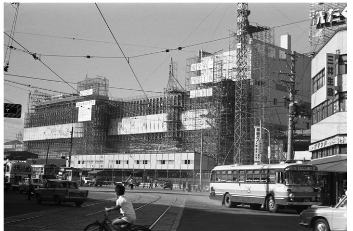
広島駅 建設中の駅ビル 昭和 40 (1965) 年夏頃
