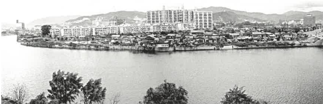
基町高層住宅工事中 昭和46年12月撮影
