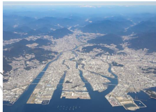
太田川下流域 (都市機能が集積する下流デルタ部)
