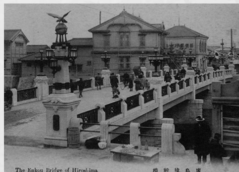
The Enkou Bridge of Hiroshima 橋登坂島廣 広島猿猴橋 (広島市公文書館所蔵)
