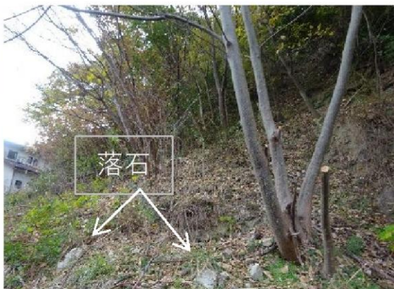
斜面が侵食・ 落石不安定
