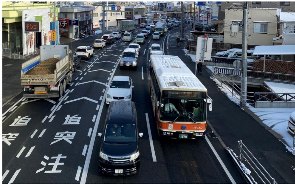
▲ 国道183号(祇園大橋北詰付近)
