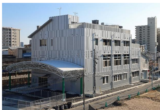
【公民館の外観（北東面）】
