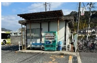
<老朽化した待合施設(郊外部)>
