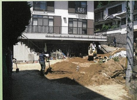
真夏の復旧作業の様子
