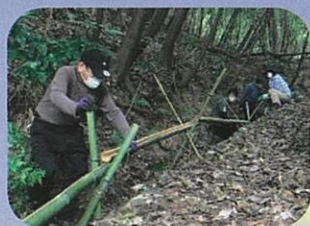
竹樋の組立て
