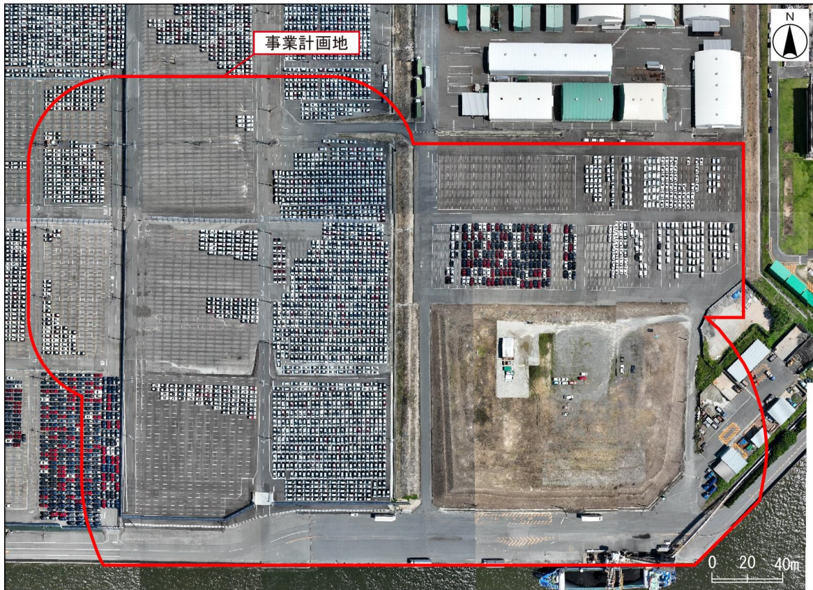
図 2-5 事業計画地の空撮写真 (令和 6 年 7 月撮影)
