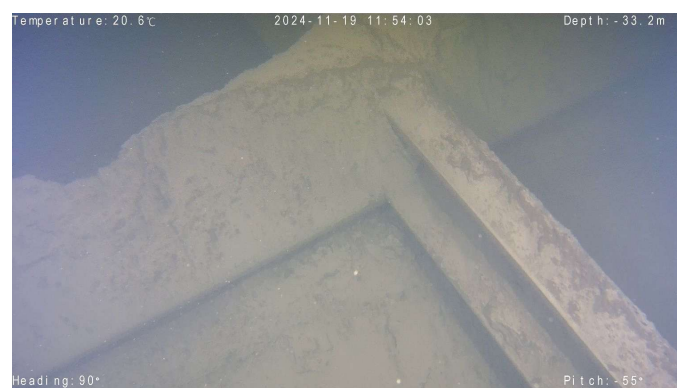
写真 4.4 トンネル坑内軌条（枕木・レール交差部）
