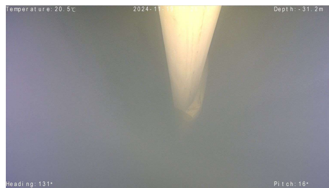
写真 4.2 トンネル坑内上部送風管
