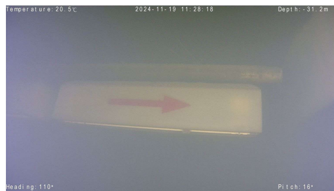
写真 4.3 トンネル坑内表示器
