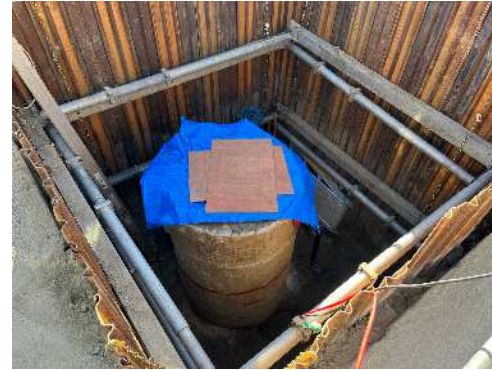
マンホール開口部 シート被覆状況
