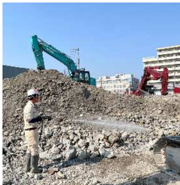
場内散水状況
