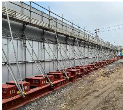
仮囲い（高さ4.5m）
