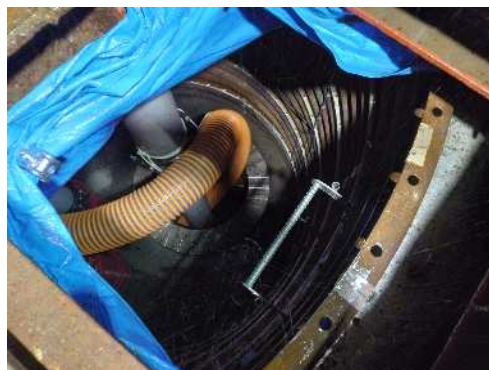
既設人孔部 シート被覆状況
