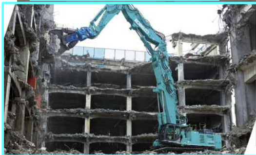
建屋解体イメージ写真
