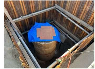
マンホール開口部 シート被覆状況
