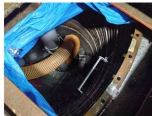
既設人孔部 シート被覆状況
