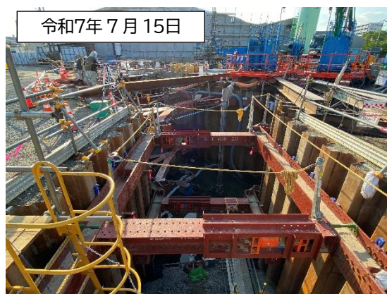
下水道管復旧状況
