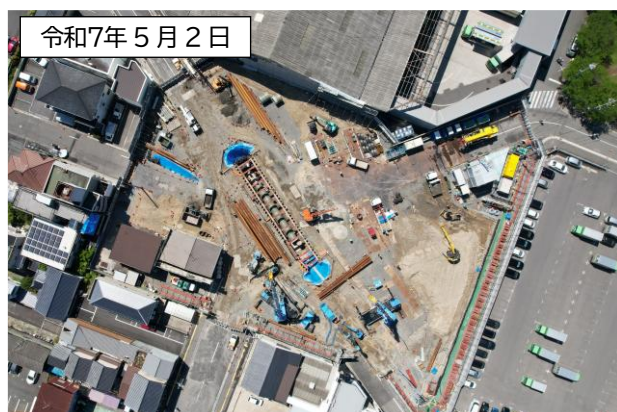
建物解体状況(上空写真)
