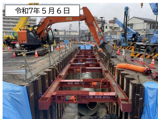
下水道管復旧状況
