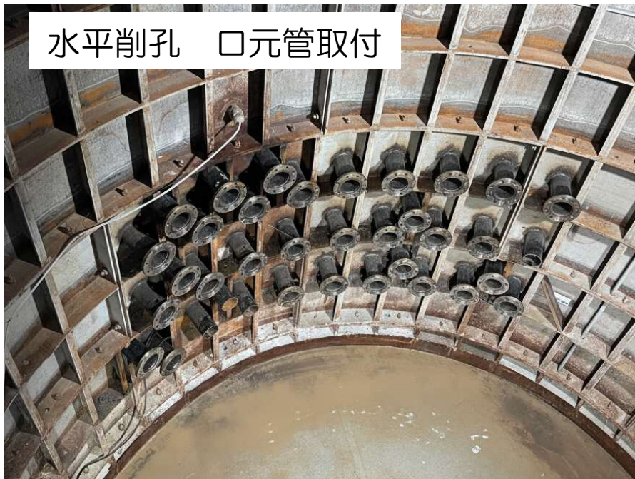
水平削孔状況
