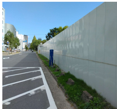
仮囲い（高さ3.0m）
