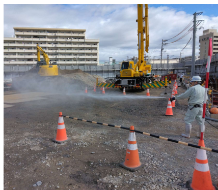
場内散水状況
