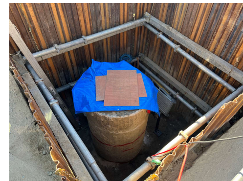
マンホール開口部 シート被覆状況
