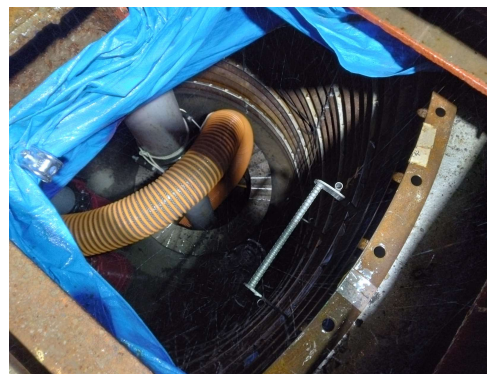
既設人孔部 シート被覆状況
