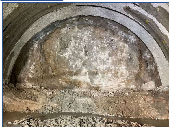
トンネル施工状況
