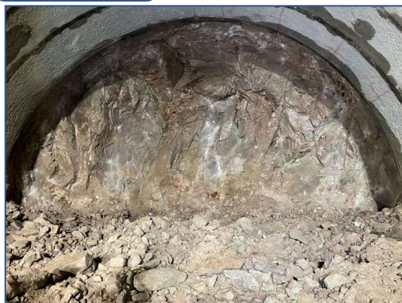
トンネル施工状況
