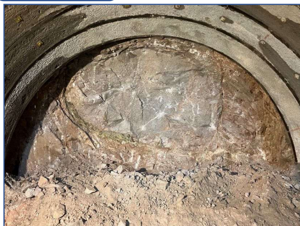
トンネル施工状況
