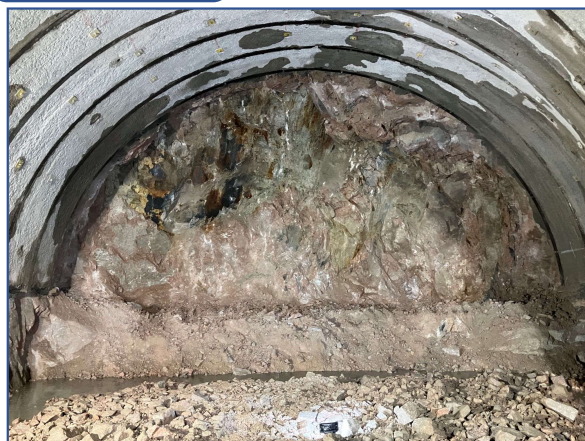
トンネル施工状況
