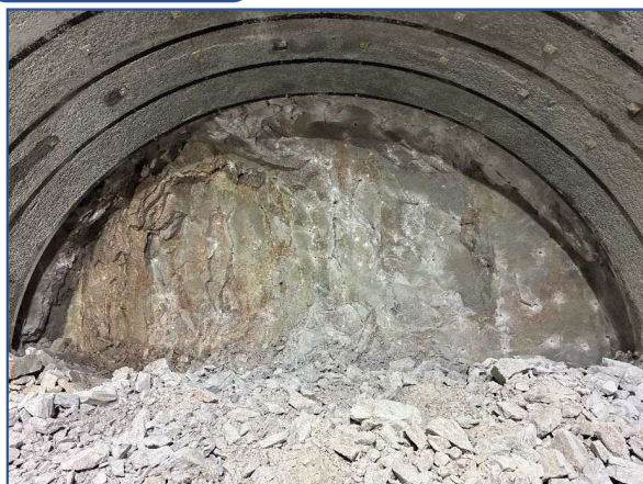
トンネル施工状況
