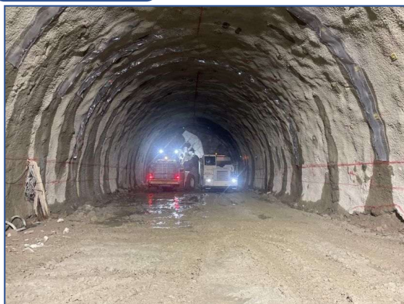
トンネル施工状況
