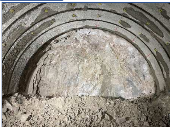
トンネル施工状況
