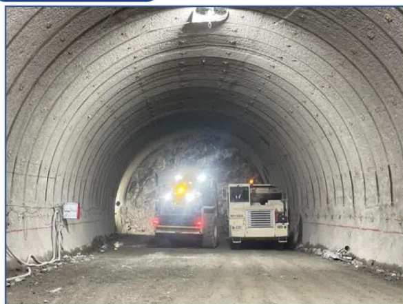
トンネル施工状況
