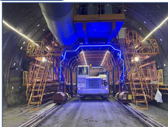
トンネル施工状況
