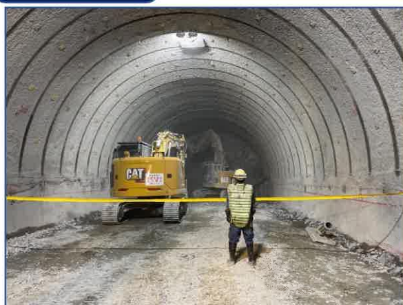
トンネル施工状況
