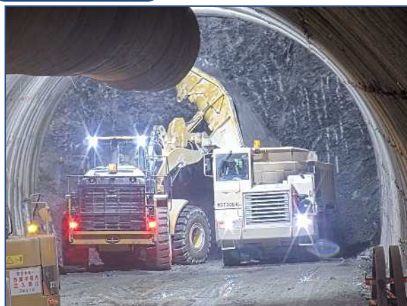
トンネル施工状況
