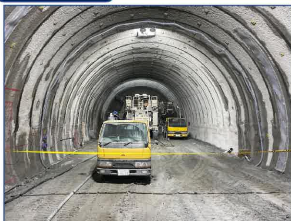
トンネル施工状況
