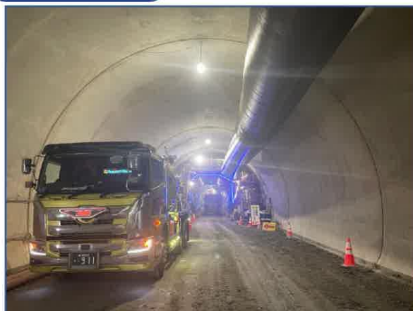
トンネル施工状況
