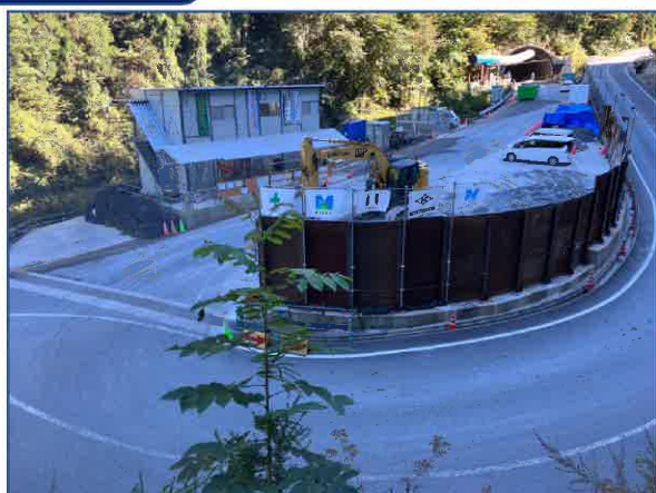
施工ヤード全景
