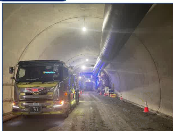
トンネル施工状況
