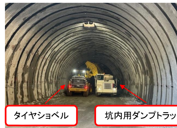
坑内土砂（ズリ）積込状況
