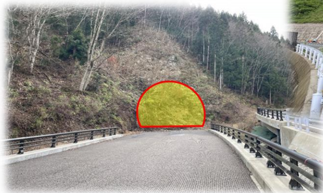
湯来側トンネル入口
