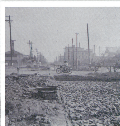
拡幅工事中の鯉城通り
