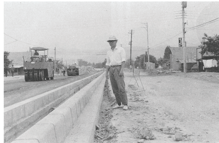
舗装工事中の城南通り
