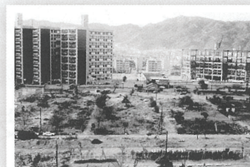
建設中の基町高層住宅
