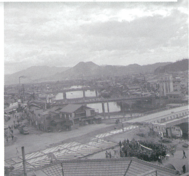
架け替え工事中の駅前大橋
