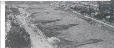
広島城内堀の改修工事
