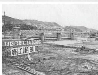
建設中の祇園水門
