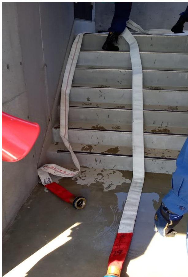
9 破裂したホースの交換
