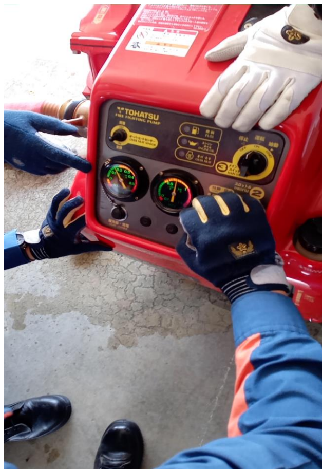
10 圧力計と連成計の安定を確認
