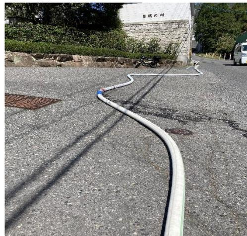
第1可搬ポンプから送られてきた水を順次、第2可搬ポンプ～第3可搬ポンプ～第4可搬ポンプと加圧して遠距離に水を送っていきます。
