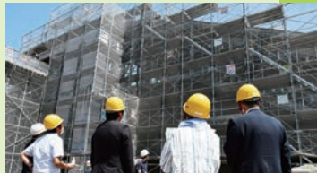
西広島駅自由通路等整備工事現場視察（7月撮影）
