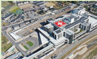
北部医療センター安佐市民病院新築工事（11月撮影）
