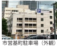
市営基町駐車場(外観)
