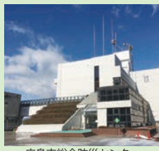
広島市総合防災センター
