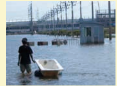
タイ国チャオプラヤ川で発生した大洪水による影響 【出典】国土交通省ホームページ
