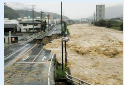
平成30年7月豪雨災害（広島市安芸区）
