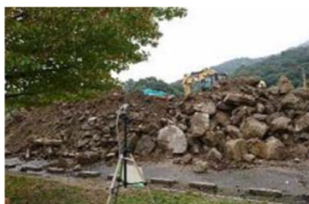
図 アスベスト大気濃度調査の状況 (瀬野川公園, 検体 No. 18)
