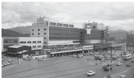
民衆駅として完成した広島駅ビル （昭和40年（1965年））
