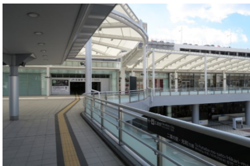
工事が進むエキキタ周辺
