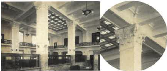
【建築当時の写真：提供 清水建設広島支店】
