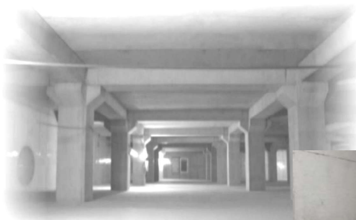
大州雨水貯留池の内部
